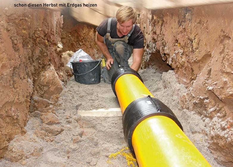
→ Alexander Scherf von der Firma Martin Weitbrecht Rohrleitungsbau GmbH fügt die einzelnen Rohrstücke mit Muffen zusammen.
